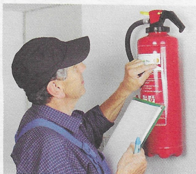
Gasilni aparat mora imeti navodila za uporabo, vsako leto ga mora pregledati pooblaščen oseba.
