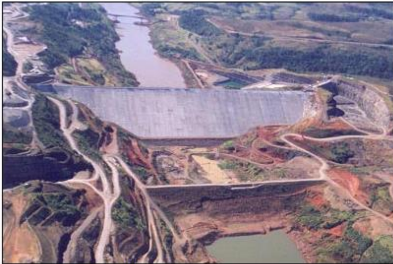
Gradnja hidroelektrarne za oskrbo industrijskih obratov
